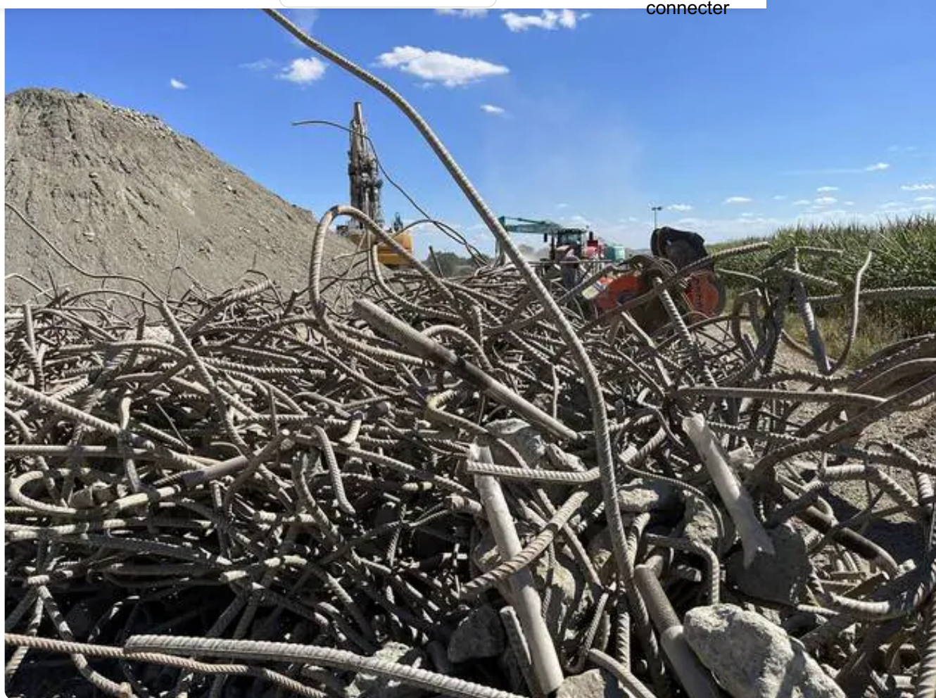
Sur le chantier, des tonnes de ferrailles doivent être retirées. | OUEST-FRANCE
