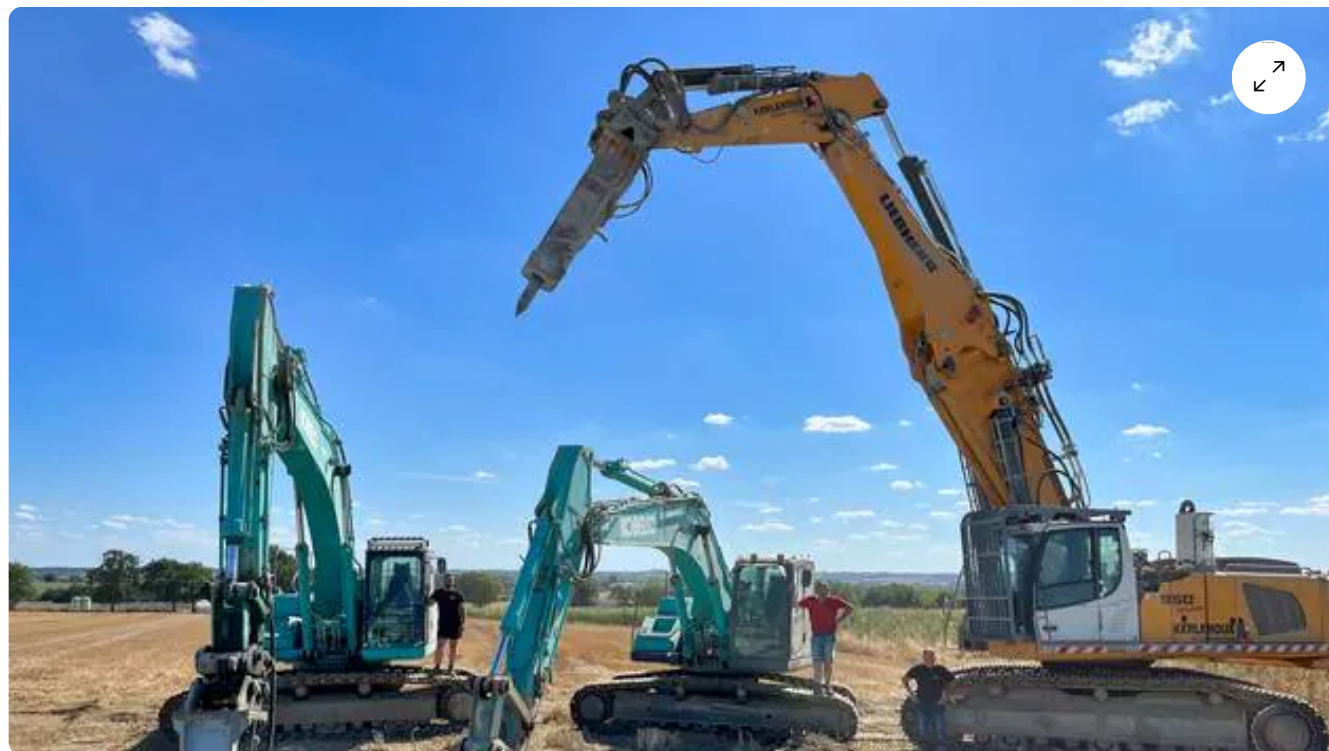
Des brises roches de 70 tonnes grignotent les 500 m 3 de béton de chaque socle d'éolienne | OUEST-FRANCE
